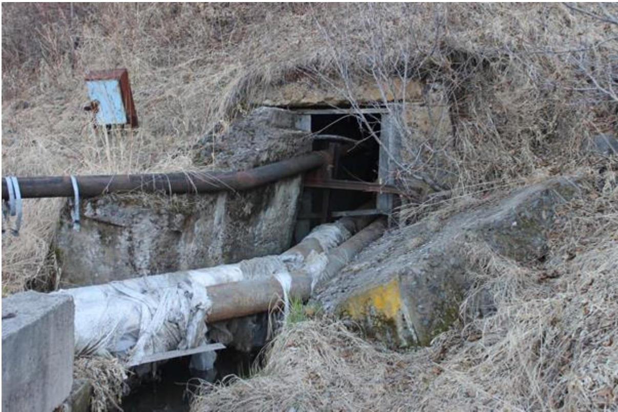
Рисунок 5.3.3. Водопропускная труба на ручье Нанте под ж.д. насыпью
